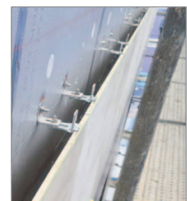
날개 조정판 T형 시공
